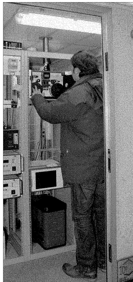
Un tecnico dell'Arpa al lavoro su una centralina per ricavare i dati delle polveri sottili, in base ai quali si decidono le limitazioni al traffico
